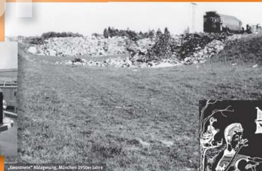
„Geordnete“ Ablagerung, München 1950er Jahre
